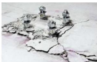
Выкалывание бетонного основания за анкером
